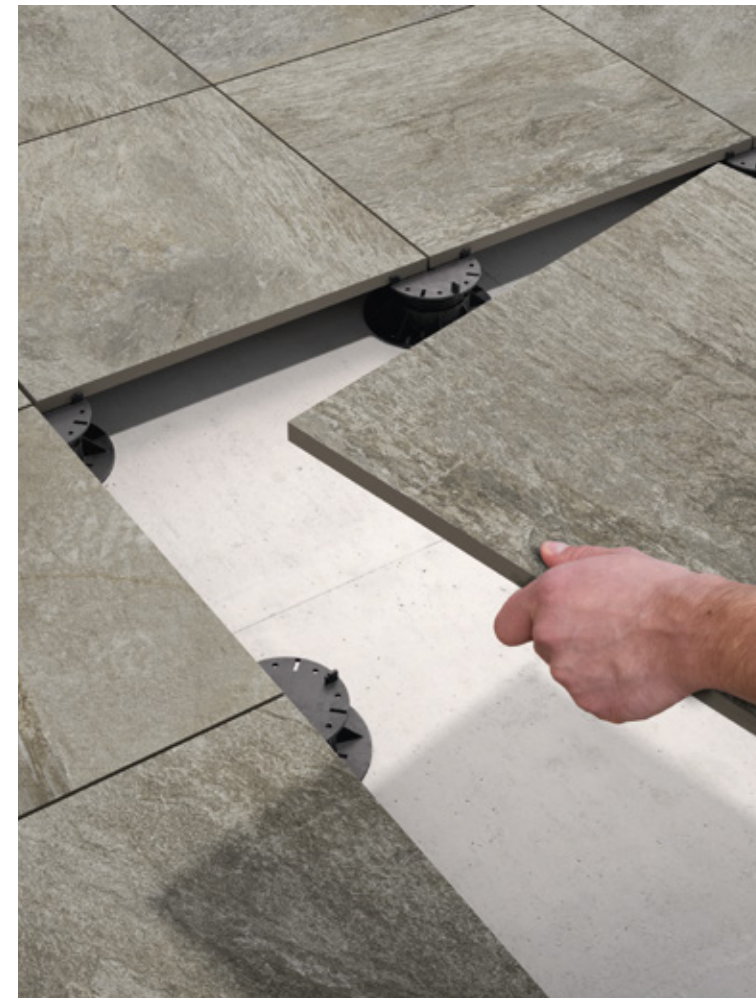
Укладка плитки My Earth Outdoor на регулируемые основы
