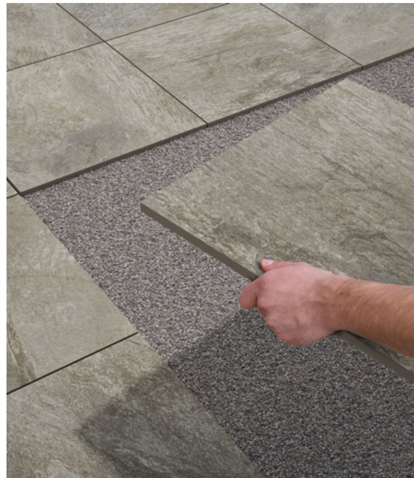
Укладка плитки My Earth Outdoor на гравий
